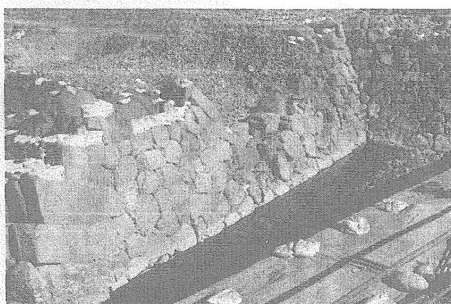
写真3 天守台南辺（中央）と本丸側（右）の石垣。南西隅付近は、四角い石で積み替えられている（切り込み接）。
